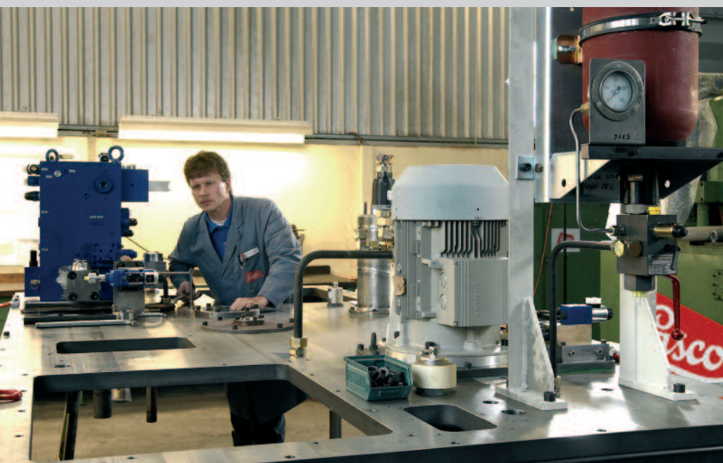
Employé LASCO lors du montage du groupe hydraulique d'une VPE.
